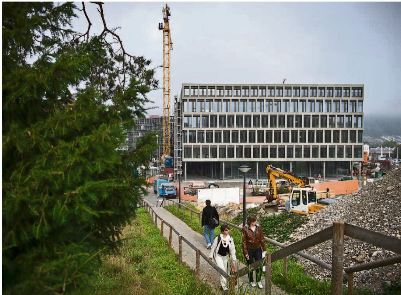
Mit Riesenschritten kommt der Bau des Riesenprojekts Campus voran.
