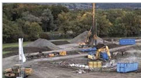
Von der Baustelle Mülimatt ...
