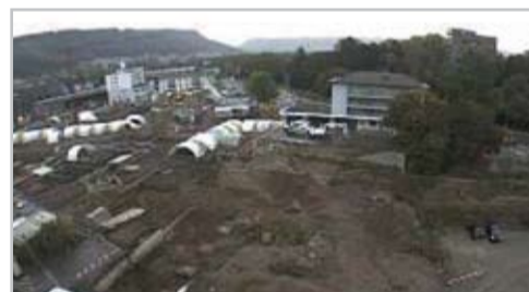
Von der Baustelle Markthalle ...
